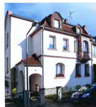
Vorzustand, noch ohne Medaillon über dem Eingang
