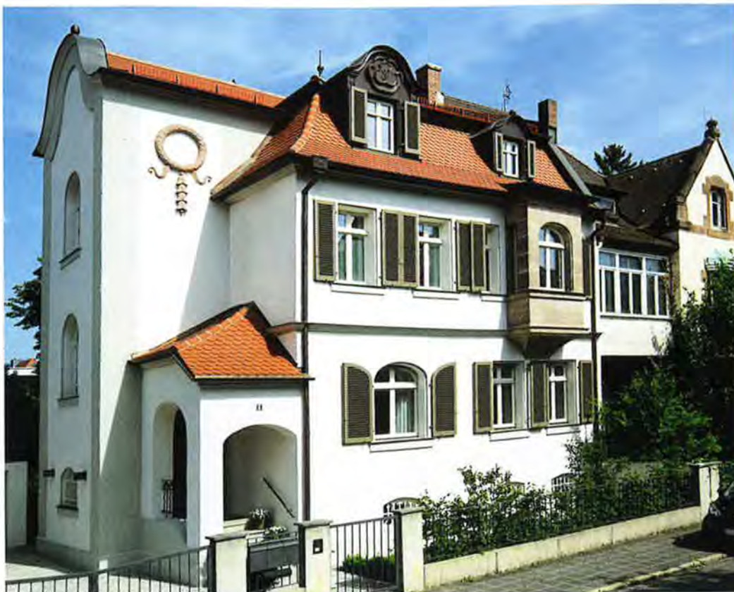
Die sanierte Villa von Nordwesten gesehen
