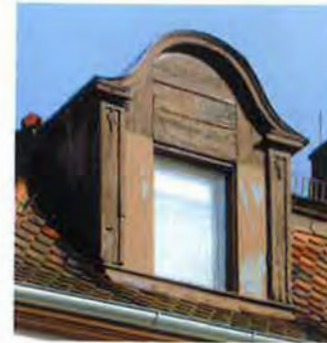
Vorzustand der Dachgaube 2013
