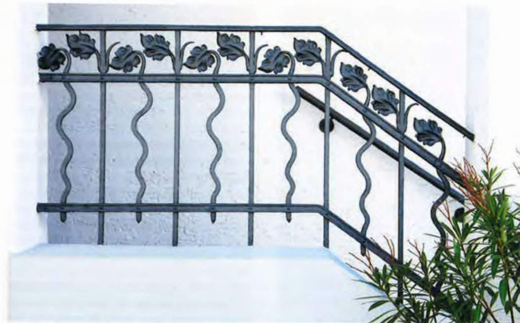
Auch Details wie das Eingangsgeländer wurden sorgfältig aufgearbeitet
