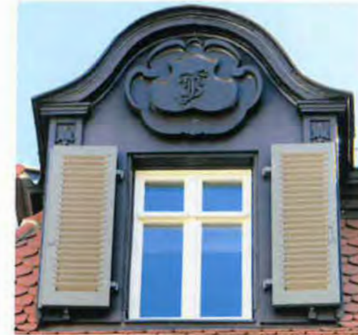
Die restaurierte Dachgaube mit rekonstruierter Schmuckkartusche
