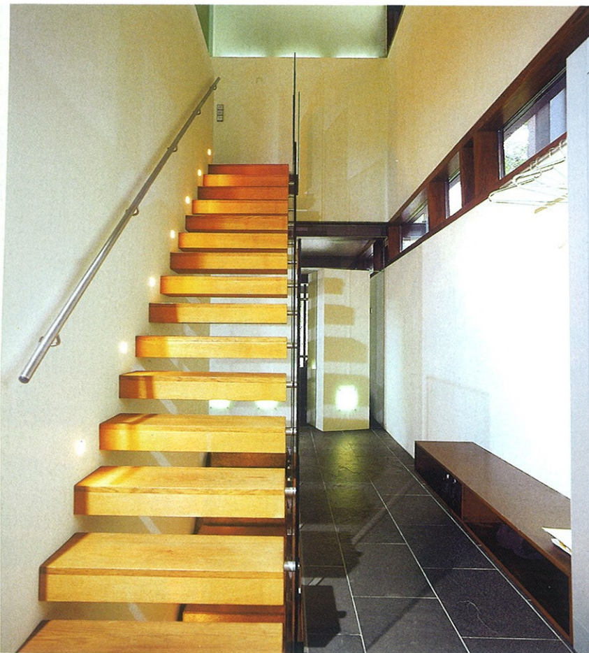
Hinter der Wandscheibe mit Treppe befindet sich der Essplatz. Alle Räume des Hauses sind mit brasilianischen Schieferplatten belegt. Bis auf die Lüftungsklappen sind die Fensterfronten festverglast.
