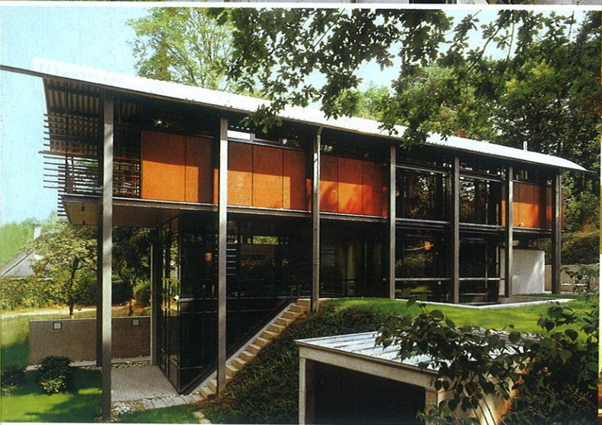
Stahlskelett, grosse Glasflächen und Tonnendach sind die bestimmenden Elemente des langgestreckten Hanghauses, dessen Längsseite sich nach Süden richtet.
